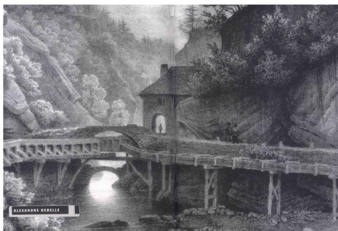
Fig : Fourvoirie : G150 (métallurgie), G155 (scierie), G157 (fabrique de pâte de bois), G165 (scierie) et G160 (moulin) : les canaux en bois accrochés aux parois rocheuses des berges au XIXe siècle (Debelle A.)
